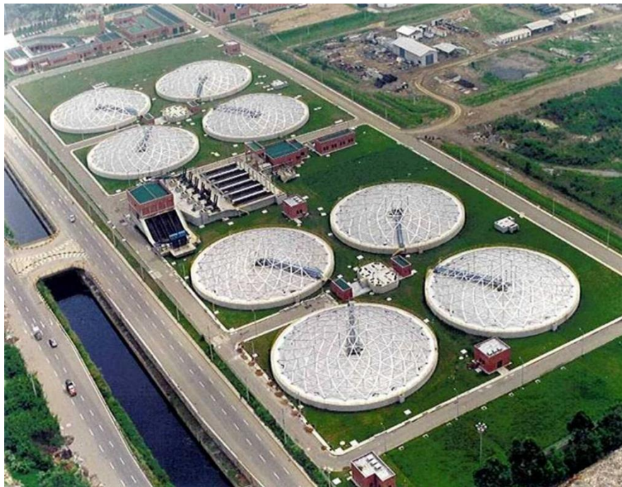
Imagen 2 Vista aérea de la PTAR
