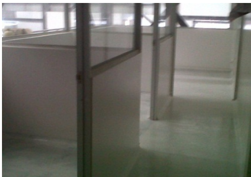
Figura 7. Área de reempaque alimenticio terminada la adecuación
