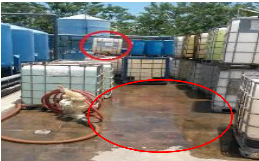
Figura 13. Derrame de 700 litros de NaOH al 50%. Área de almacenamiento de ósmosis de Quimicol S.A.
