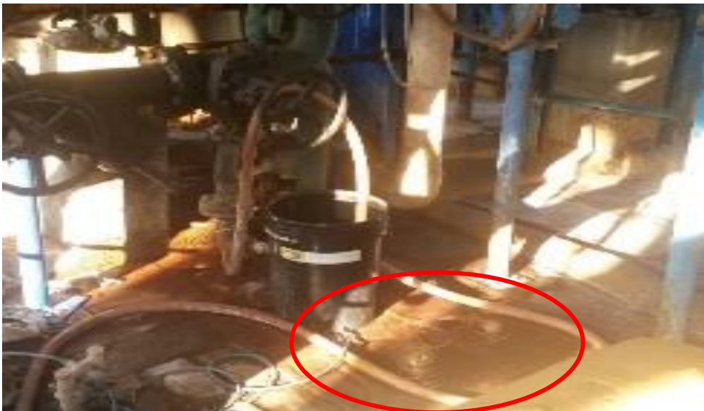
Figura 12. Derrame de NaOH al 50% en la salida del intercambiador 240 en la planta 1 de Quimicol S.A.
