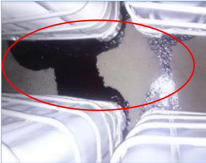
Figura 14. Derrame líquido de \text{FeCl}_3 , área de despacho de Quimicol S.A.
