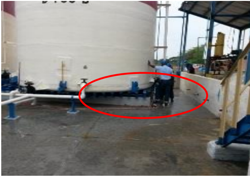
Figura 9. Derrame de HCl, en un tanque de la planta Quimicol S.A.
