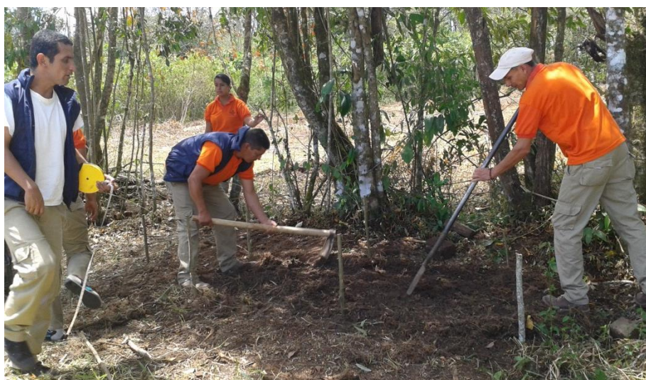
Figura 16. Adecuación y limpieza de terreno. Fuente. Autor. (2018).
