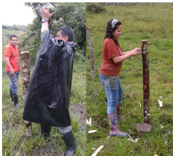
Figura 28. Instalación de postes. Fuente. Autor. (2018).
