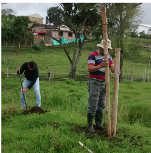
Figura 30. Instalación de 20 postes, donados por la CRC. Fuente. Autor. (2018).
