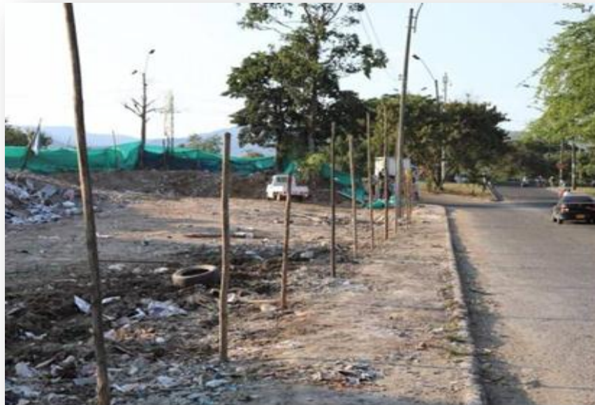
Figura 2. Estado actual de la Escombrera de la 50
