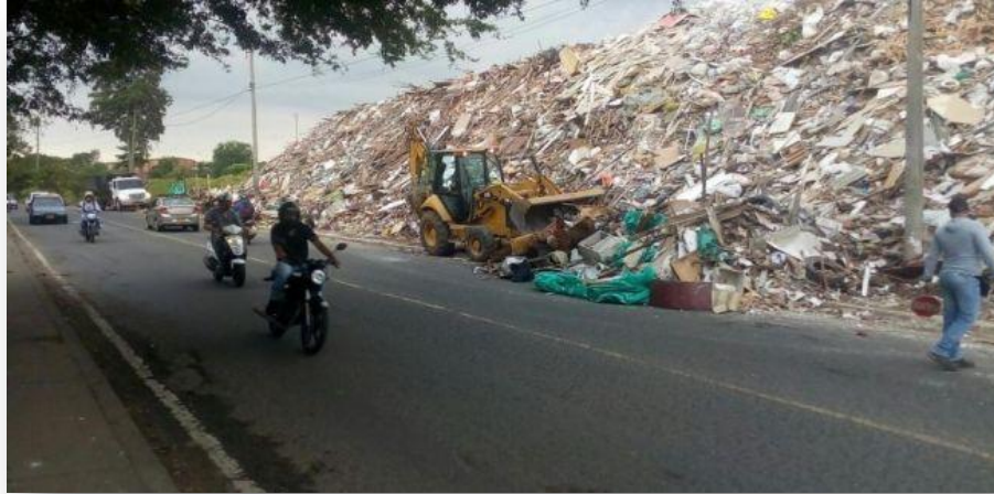
Figura 1. Escombrera de la 50 en estado de saturación de RCD
