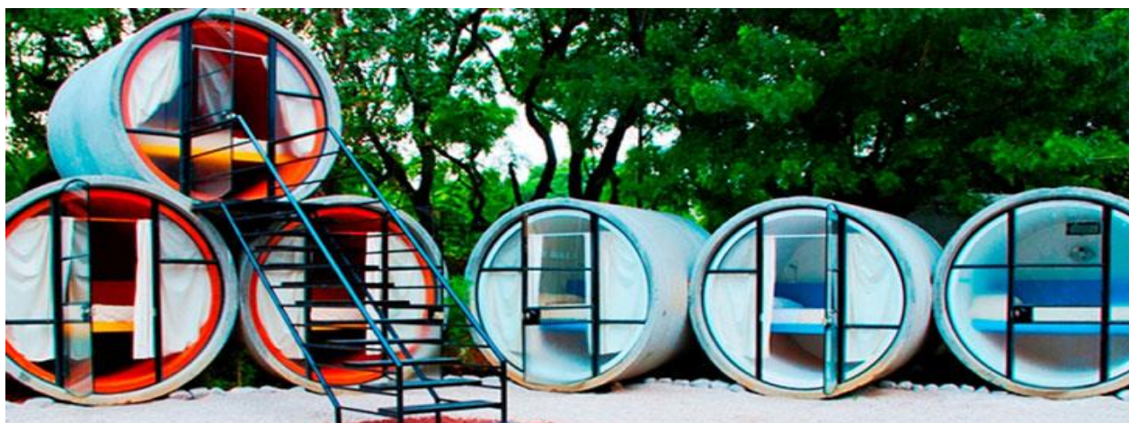
Figura 3. Uso de tubos de concreto reciclado (tubo hotel ciudad de México)
