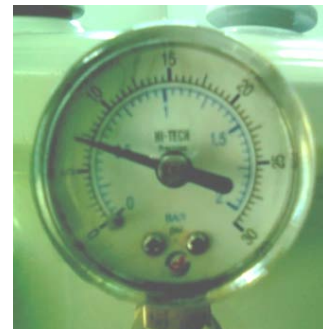
Figura 9. Presurización del transformador
