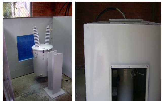
Figura 8. Montaje de la viga rígida y la cabina de pruebas
