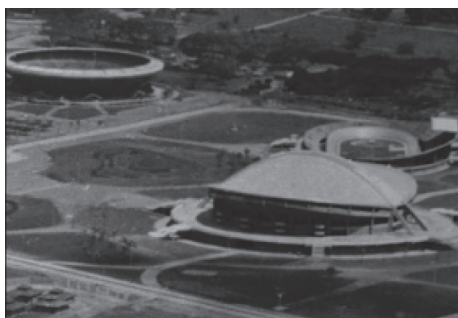
Figura 13. Coliseo construido JP.
